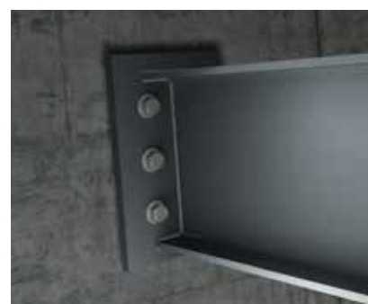
Fixation de consoles, platines et poutres acier
