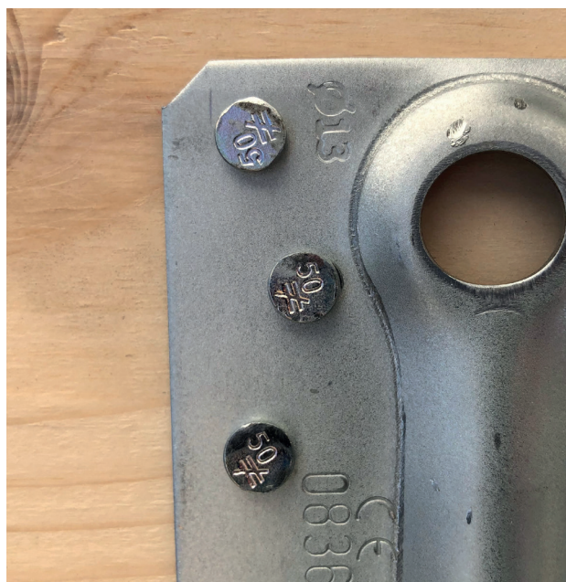
Le marquage sur le connecteur, en plus du marquage sur les têtes de pointes, permet une vérification facile après la pose.
